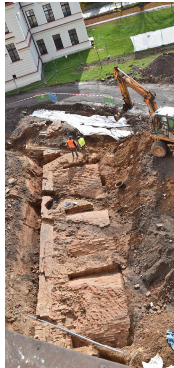
Celkový pohled na odkrytý bok bastionu VIII v Gayerových kasárnách
