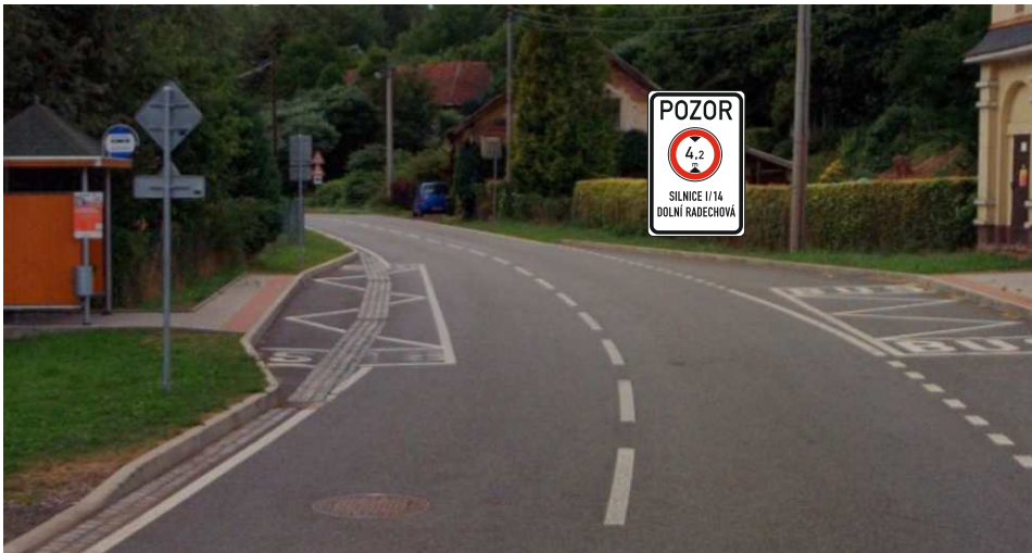
Silnice I/14 v k. ú. Horní Radechová v intravilánu obce, za křižovatkou se silnicí III/303 5 (Slavíkov).
