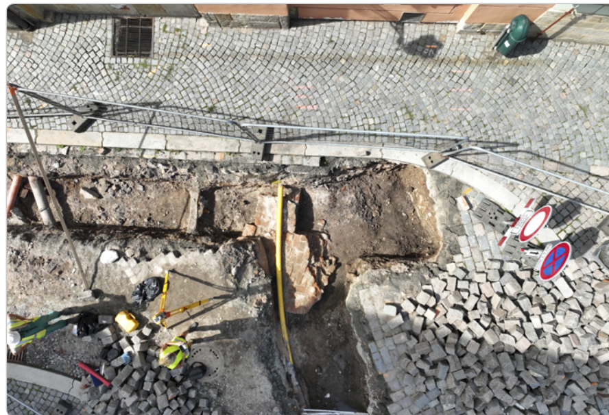
Hradec Králové, stavba teplovodu v oblasti hradeckého hradu, cihlové zdivo ze 16. století
