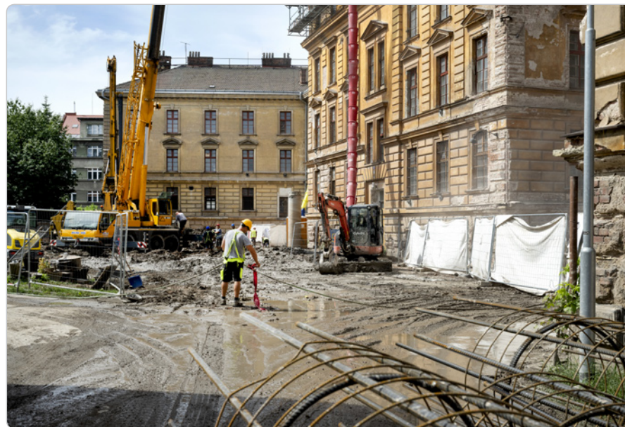
Revitalizace bývalých Vrbenského kasáren
