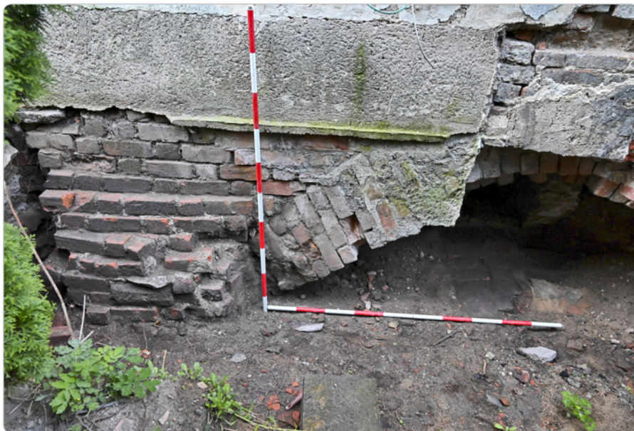
Hradec Králové, Rokitanského, základový pas renesančního domu čp. 71
