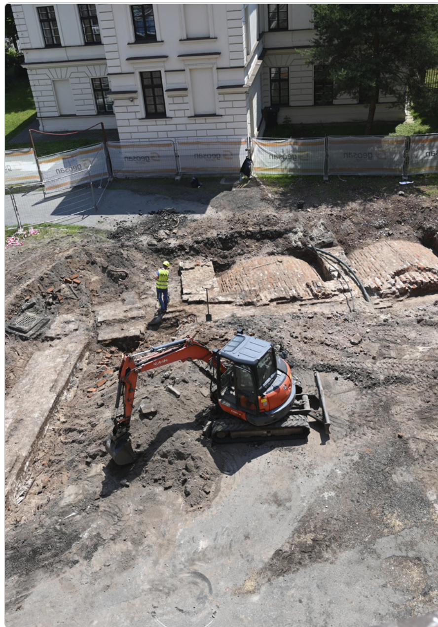
Hradec Králové, Vrbenského kasárny, dokumentace pevnostních zdí z 18. století
