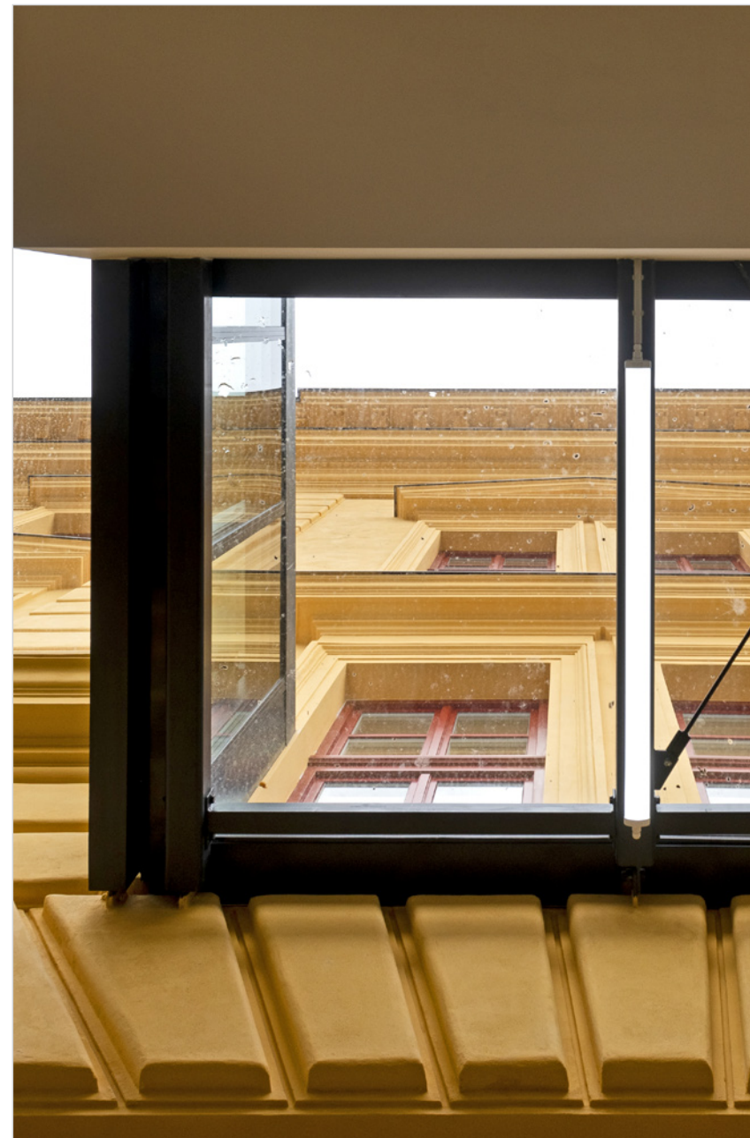
Detail spojení nové přístavby a historické budovy pracoviště v Gayerových kasárnách
