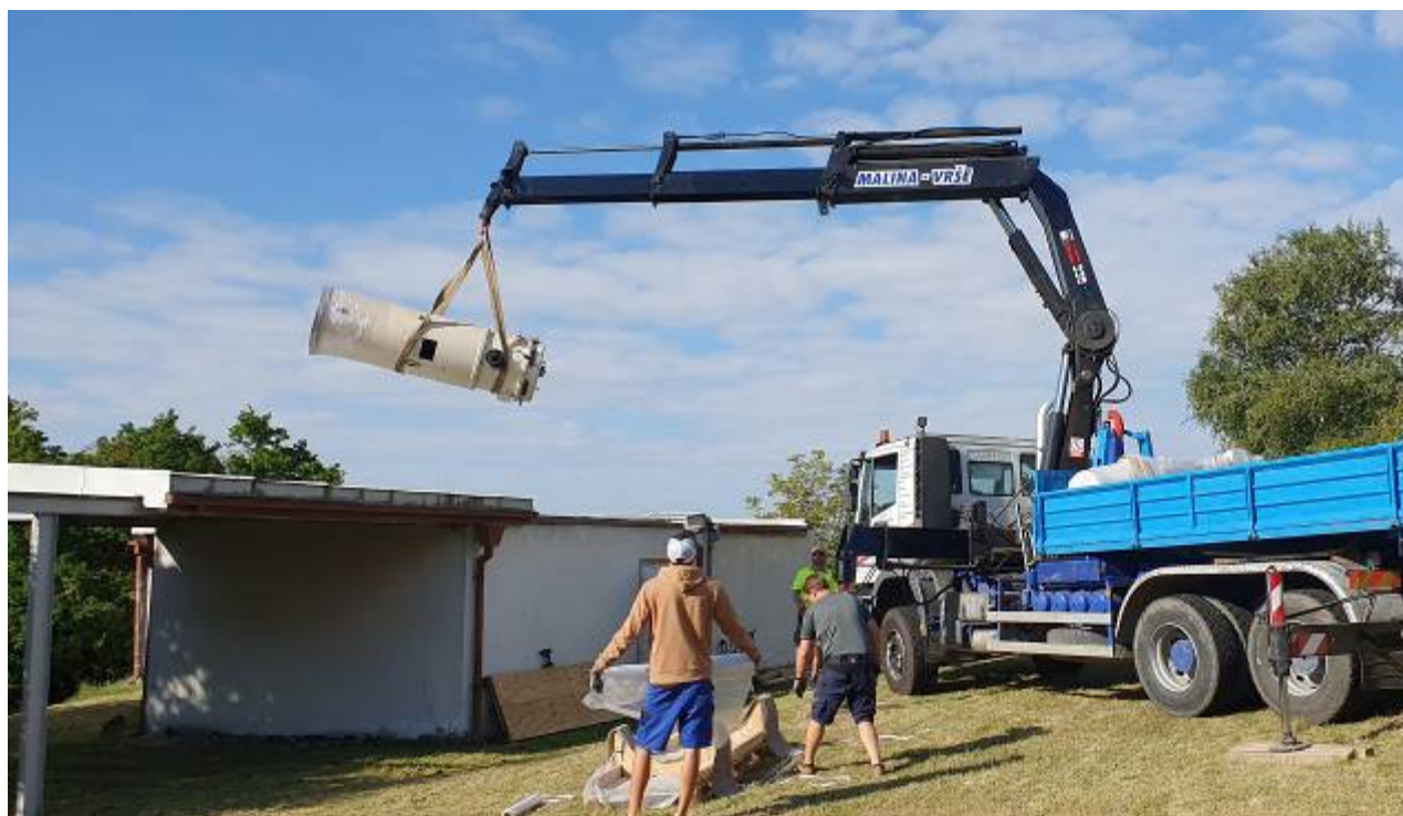
Objekt pozorovacího domku byl vyklizen a připraven na zahájení rekonstrukce, v rámci které dojde v příštím roce k odstranění původního objektu a jeho nahrazení objektem novým.
