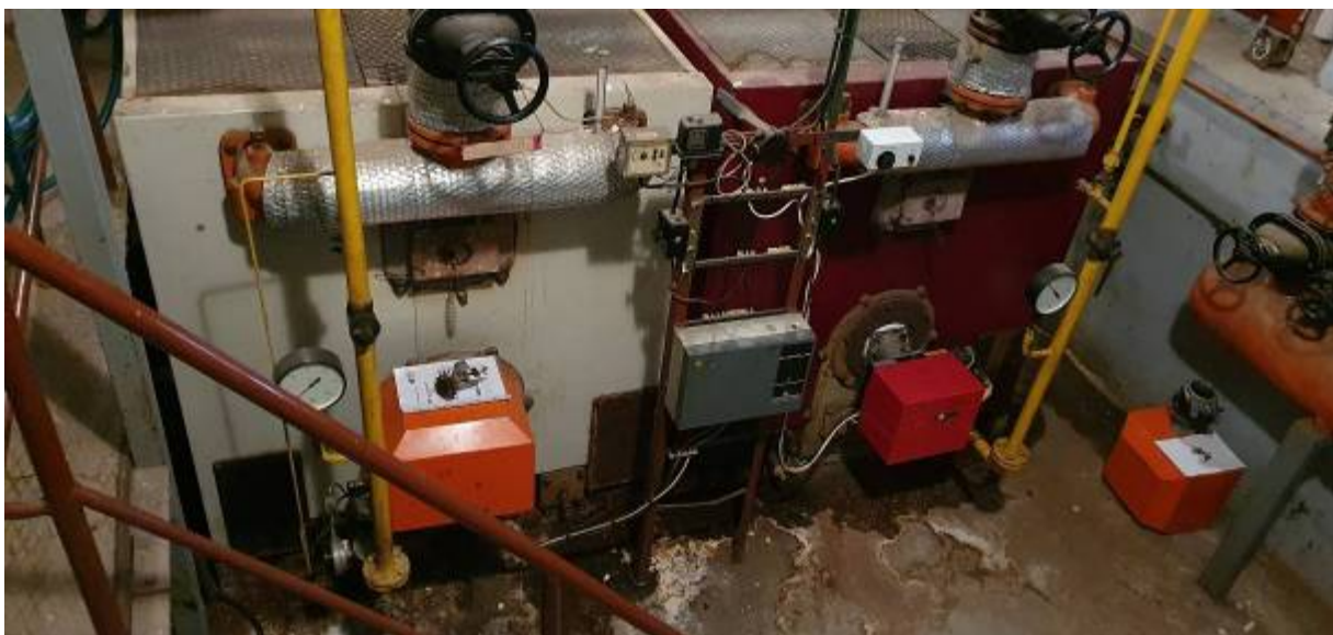
Byla provedena oprava jednoho ze dvou plynových kotlů zajišťujících vytápění hlavní budovy. (Zdroj: HPHK, M. Krejčí)
