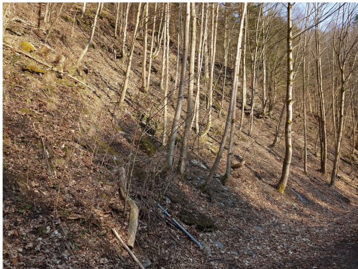
I.zóna nad silnicí – padající kamení – porost 13A5y
