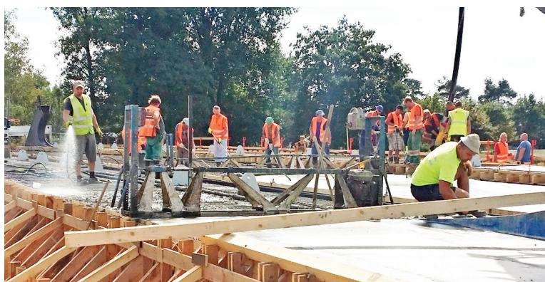
Betonáž mostu byla provedena v září.
