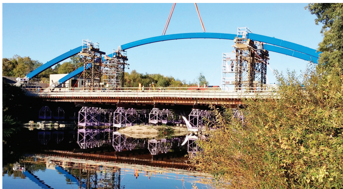
Ocelovou konstrukci montovali silničáři na přelomu září a října.
