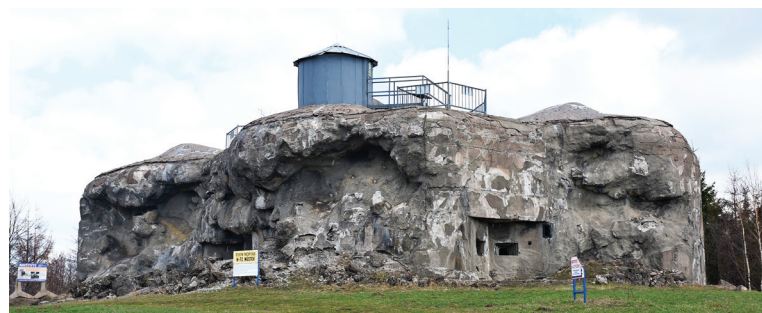
Na pěchotním srubu Můstek zkoušeli Němci nové střely Röchling.
