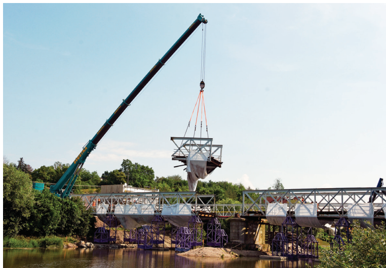
Technici starý most rozřezali na kousky.
