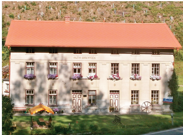
Stávající podoba mlýnu ve Dřevíčku.
