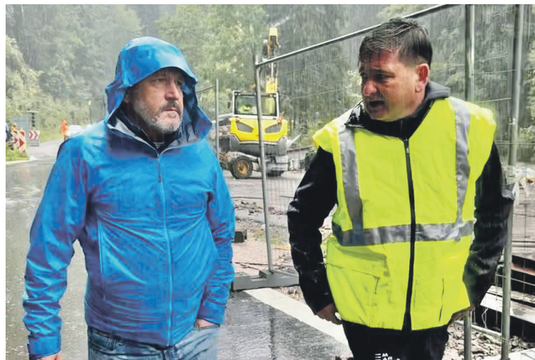
V sobotu se do Špindlerova Mlýna vypravil hejtman Martin Červíček. Na hlavním tahu do krkonošského střediska kraj opravuje mosty. Hrozilo, že řeka posune mostní provizorium a znemožní průjezd. Obavy se naštěstí nevyplnily.
