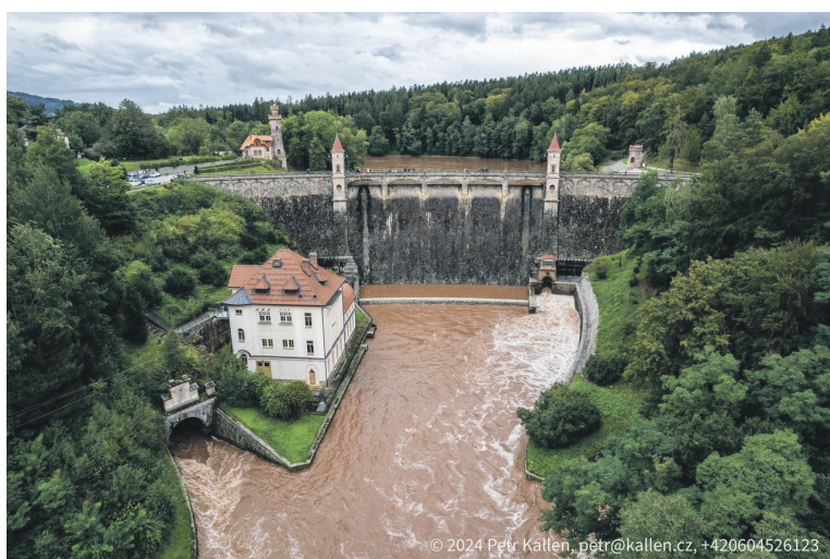
Významnou roli během povodní sehrály přehrady, které ochránily region a jeho města a obce před extrémními dešťovými srážkami, které spadly především v horských oblastech. Na fotografii přehrada Les Království u Dvora Králové nad Labem. Foto: Petr Kallen
