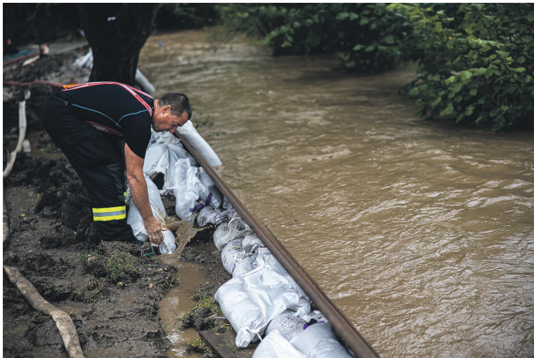
Na povodně se hasiči začali připravovat ještě před silnými dešti, před kterými meteorologové varovali. Pytle s pískem a další mobilní zábrany posloužily jako ochrana před stoupající vodou. Foto: HZS KHK
