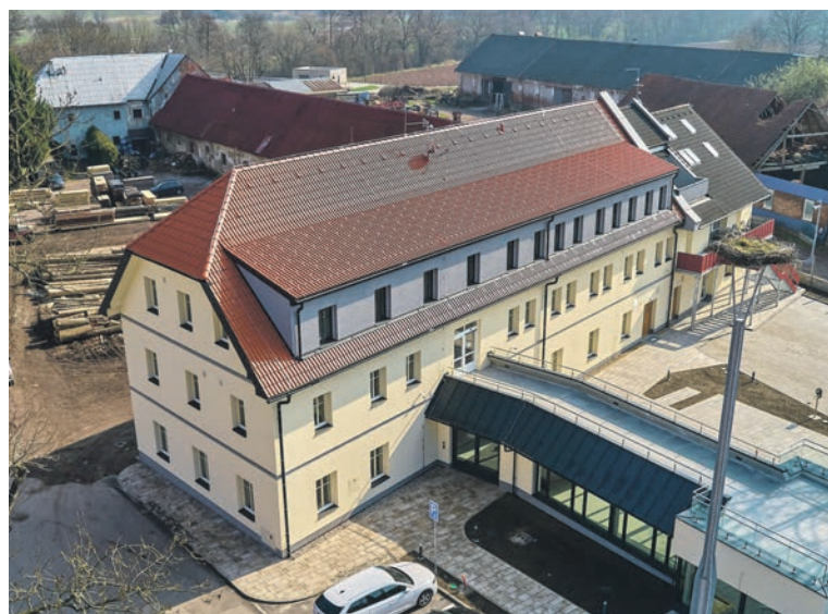
Nově opravený objekt v areálu - Dům sv. Františka.
