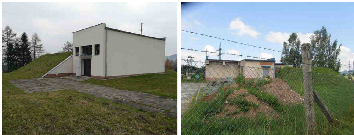
Obr.7 Hlavní vodojemy na navrhovaném přiváděči – VDJ Vysoká Srbská (vlevo) a VDJ U Bedny (vpravo, Červený Kostelec)
