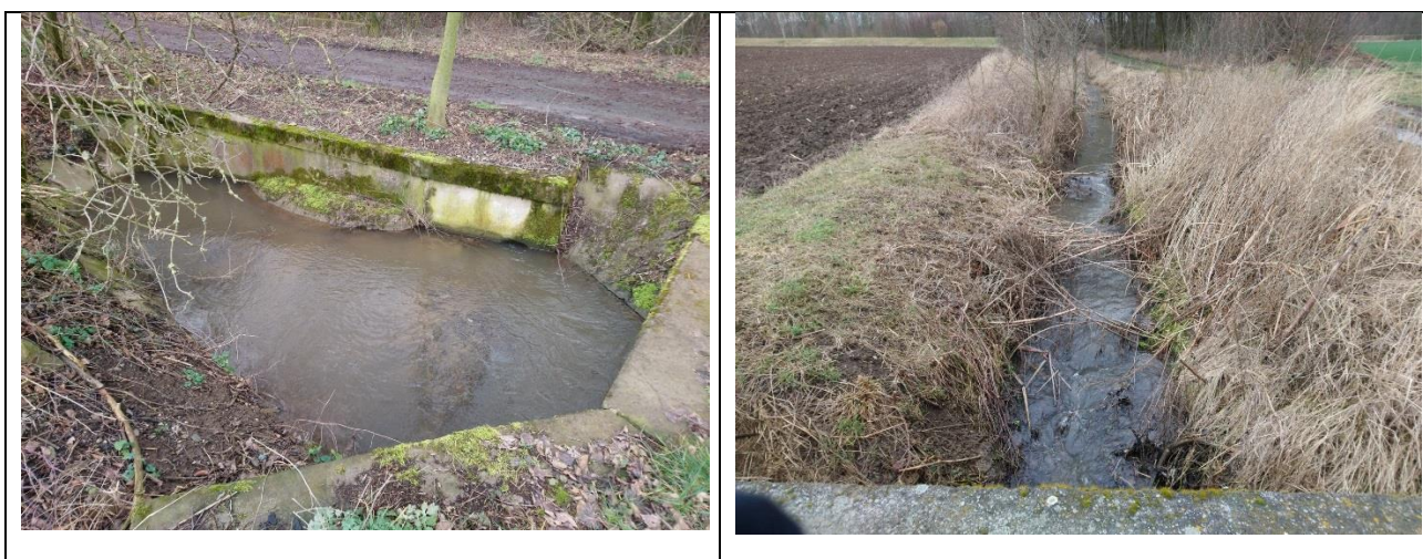
Obr. 18: Lokalita možného rozlivu na příjezdovou komunikaci z přivaděče
