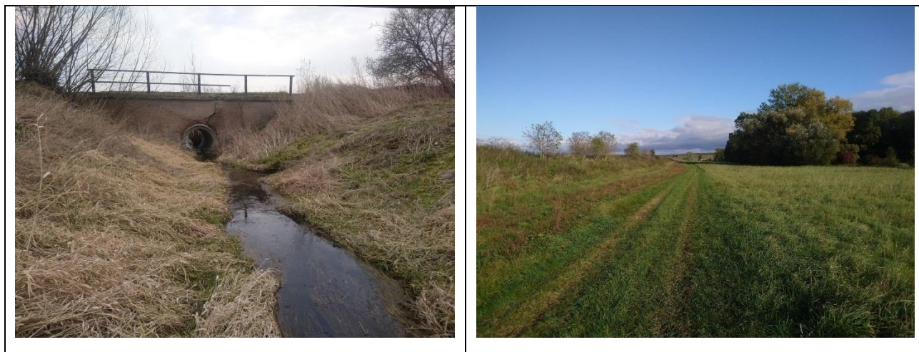
Obr. 5: Přemostění Rohenického potoka (vlevo), zemní val nad zemědělskou cestou
