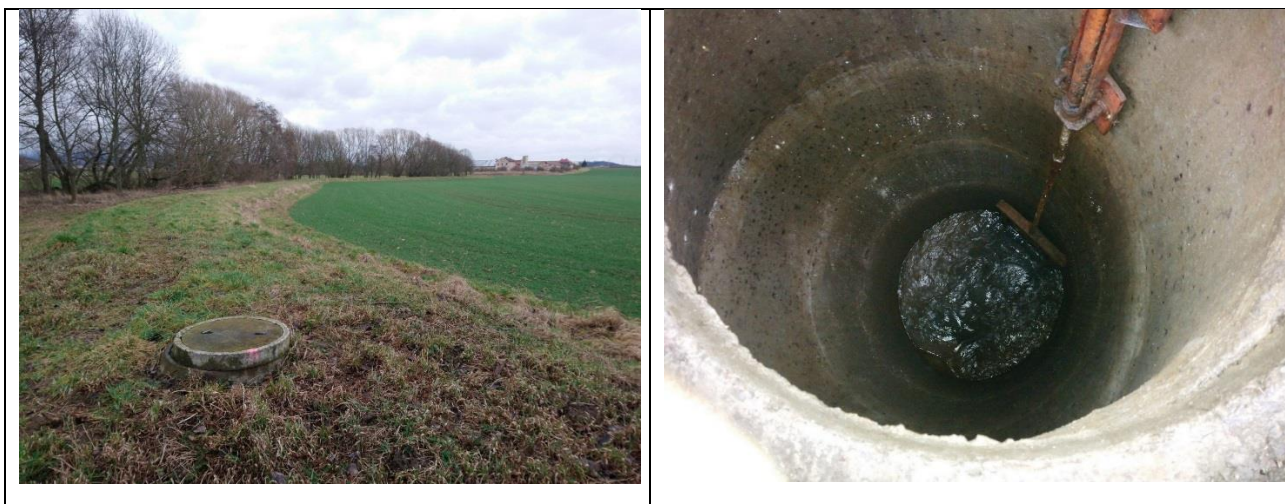
Obr. 17: Fotografie uzavíracího objektu přivaděče
