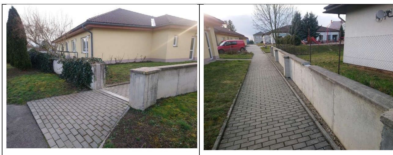
Obr. 7: Stávající ochrana citlivého objektu v Českém Meziříčí
