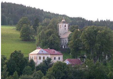
Pohled na faru a kostel Nanebevzetí Panny Marie v Horním Maršově.
